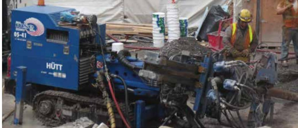
Là où la hauteur libre n'est pas à prendre en compte, les angles exagérés peuvent l'être. Quelques-uns des trous TAM ont été forés sous les murs à 6 degrés par rapport à l'horizontale.
